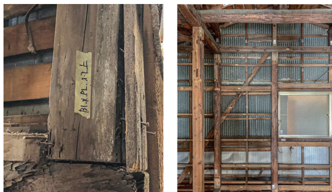
図10 解体中の ID テープと貼り付けの様子
